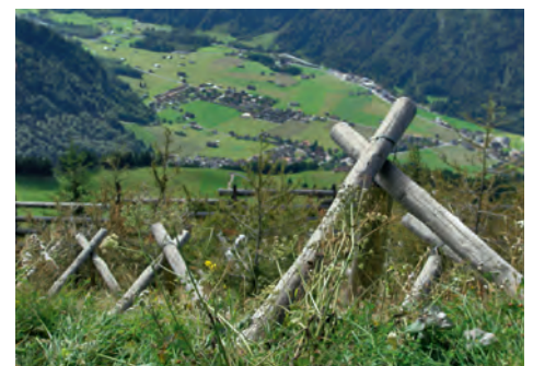
Lawinerverbauung Rigidal, Sitenwald. Foto: Sepp Hess
